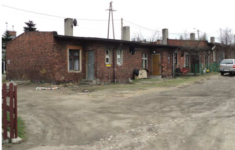
Rysunek 16. Zdjęcie przedstawia budynek mieszkalny znajdujący się w obszarze rewitalizacji nr 2
