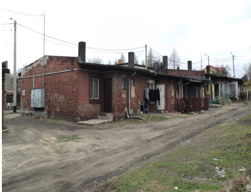
Rysunek 17. Zdjęcie przedstawia budynek mieszkalny znajdujący się w obszarze rewitalizacji nr 2
